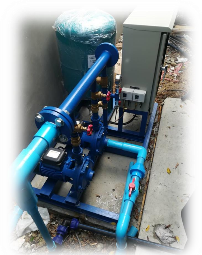
ภาพที่ 1- 7 การนำน้ำทิ้งมาหมุนเวียนใช้ในการรดน้ำต้นไม้ภายในพื้นที่โครงการ
